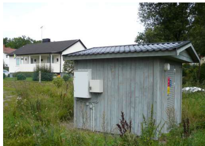
Remoção de odor para estações de bombeamento próximas a residências
